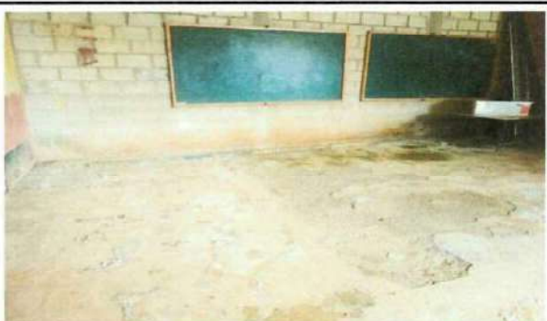
Foto 5: En el módulo de las aulas el piso se encuentra en mal estado, que amerita la sustitución de piso de torta de concreto.
